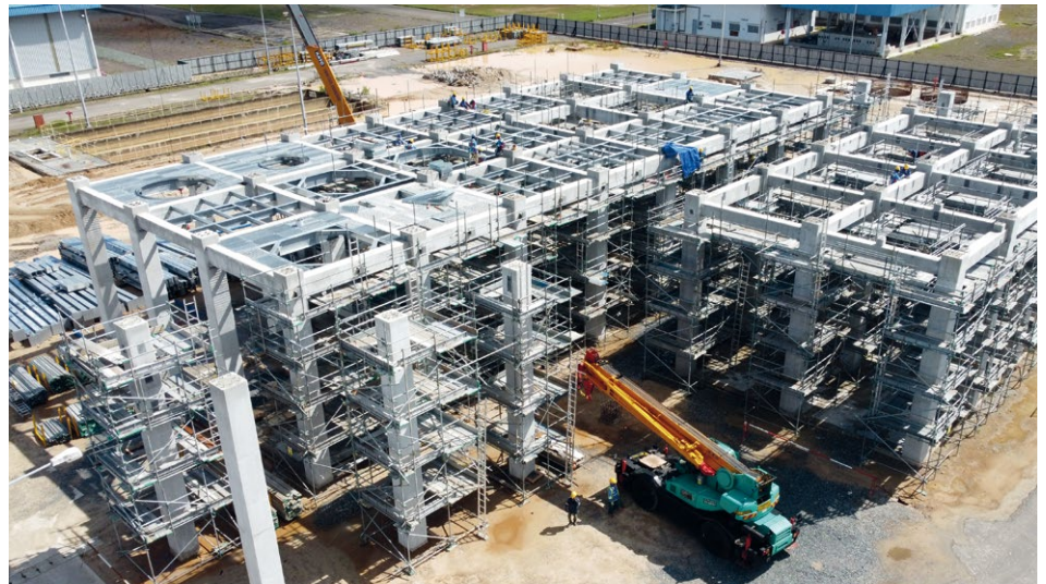
In Malaysia errichten wir in einem Joint Venture mit der PETRONAS Chemicals Group Berhad eine Produktionsanlage für Alkoxylate. Die Bauarbeiten schreiten planmäßig voran. Das Bild zeigt die Baustelle im März 2022.
