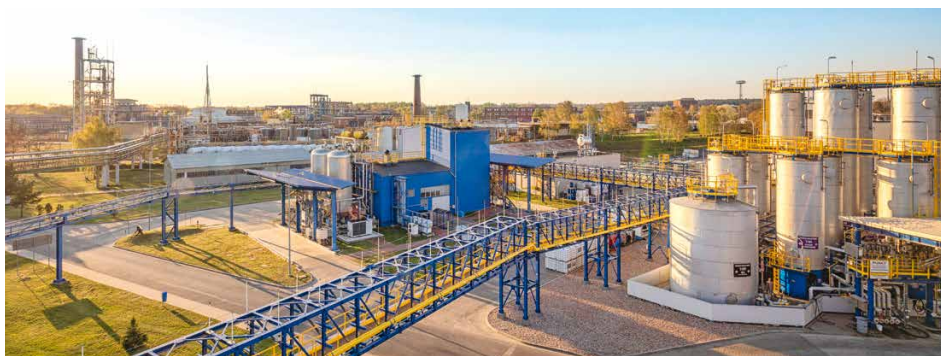
Die Chemiesparte der PCC schloss das erste Quartal 2021 äußerst erfolgreich ab und übertraf dabei sowohl die positiven Vorjahreswerte als auch die für das erste Quartal 2021 gesteckten Ergebnisziele deutlich. Hier im Bild der Chemiekomplex der PCC Rokita SA in Brzeg Dolny.
