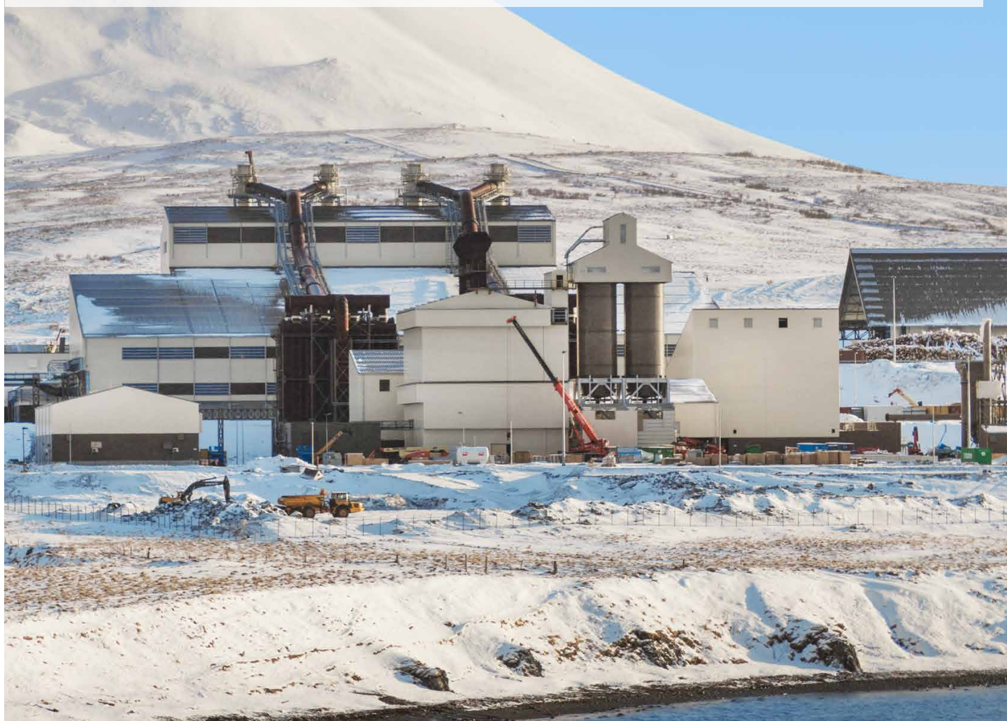
Großbaustelle der PCC BakkiSilicon hf im Norden Islands im Februar 2018: In der Bildmitte ist im Hintergrund das Ofenhaus zu sehen, in dem sich die beiden Lichtbogenöfen befinden. Die Inbetriebnahme ist für Ende März/Anfang April vorgesehen.
