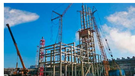
Dimethylether-Anlage in der Tula-Region (Russland): die Baustelle im November 2017
