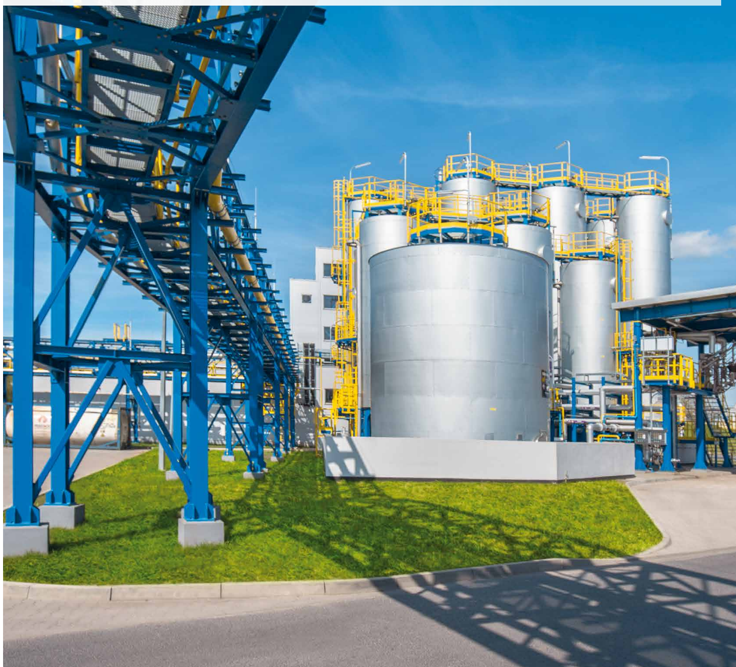
Moderne Produktionseinrichtungen am größten Chemiestandort der PCC-Gruppe in Brzeg Dolny (Polen). Im Bild: das Tanklager der neuen Produktionsanlage für Polyester-Polyole der PCC Rokita SA
