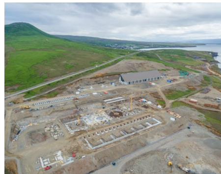
Überblick über die Baustelle der PCC BakkiSilicon mit Ofenfundament in der Bildmitte
