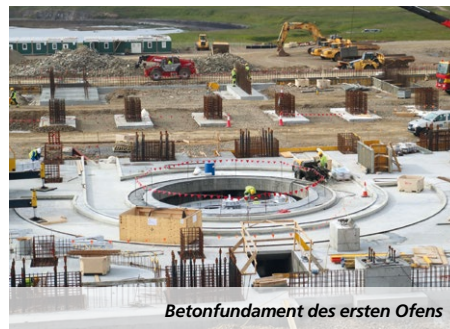
Überblick über die Baustelle der PCC BakkiSilicon mit Ofenfundament in der Bildmitte
