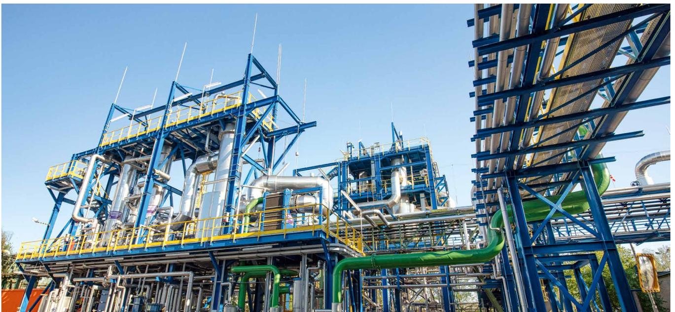
Die PCC Rokita SA leistete 2020 erneut einen wesentlichen Beitrag zum Konzernergebnis. Hier im Bild die moderne Membranelektrolyse-Anlage zur Chlor-Produktion dieser Konzerntochter in Brzeg Dolny.
