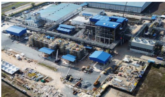
Der Bau einer Produktionsanlage für Alkoxylate in Malaysia ist aktuell ein zentrales Investitionsprojekt der PCC-Gruppe.
