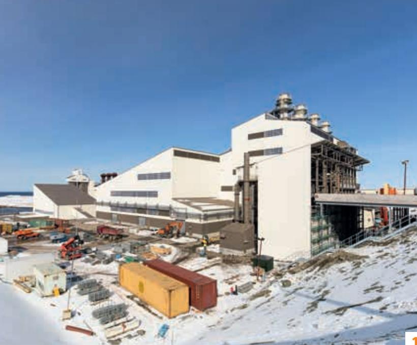
**1** Die neue Siliziummetall-Anlage in Island im April 2018: im Vordergrund die Tagesbunker für die Rohstoffzufuhr und im Hintergrund das Ofengebäude.
