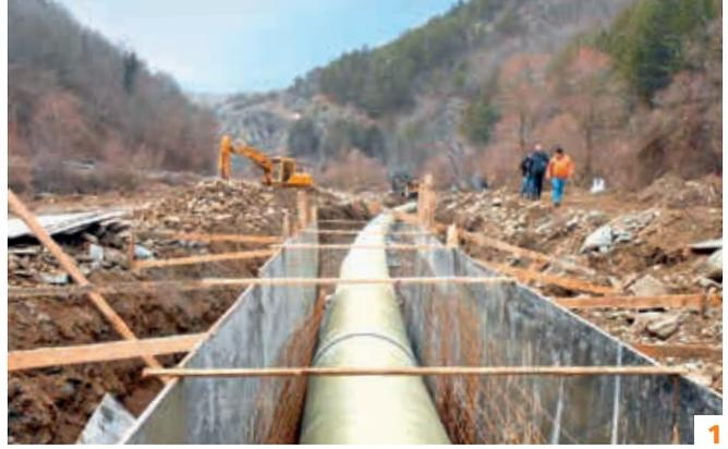
**1** In Mazedonien konnten wir 2017 endlich mit dem Bau unseres sechsten Kleinwasserkraftwerks beginnen (im Bild: der erste Bauabschnitt der 5 km langen Druckrohrleitung).
