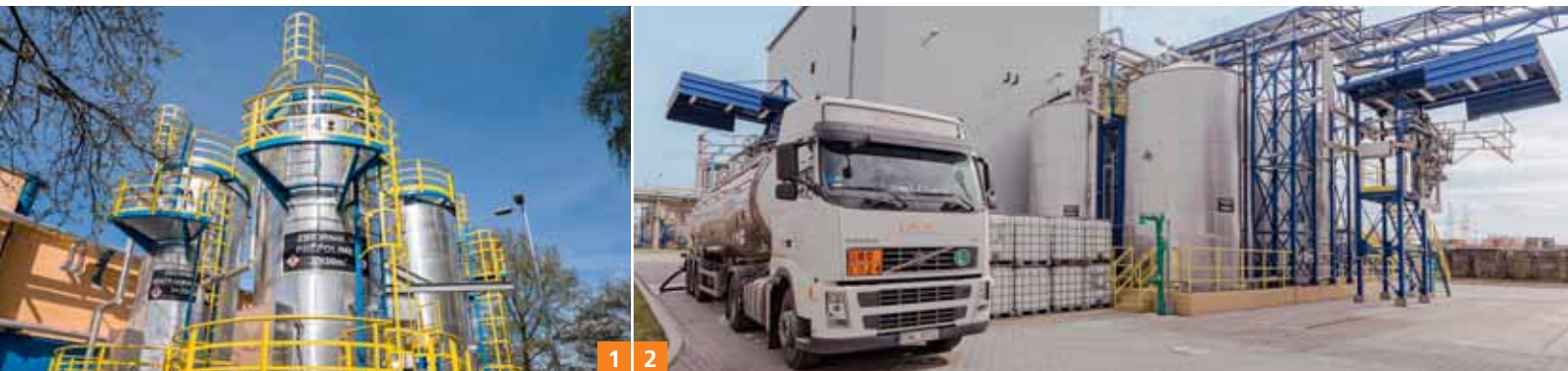
1 Tanklager der neuen Prepolymere-Anlage der PCC Prodex Sp. z o.o. Sie zählt mit einer Jahreskapazität von 7.500 Tonnen zu den drei größten dieser Art in Polen. 2 Die PCC Exol SA nahm 2016 eine Betaine-Produktionsanlage mit einer Jahreskapazität von 10.000 Tonnen in Betrieb.
