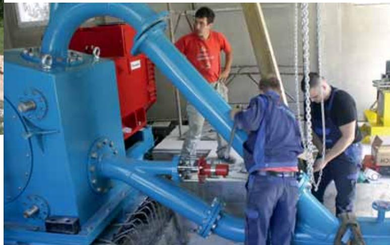
Kraftwerksstandort „Gradečka“ (Mazedonien) – oben: Rohrzwischenlager – die Verlegeleistung liegt durchschnittlich bei sechs Rohren beziehungsweise 36 Metern pro Tag; rechts: Installation der zweidüsigen Pelton-Turbine im Turbinenhaus.
