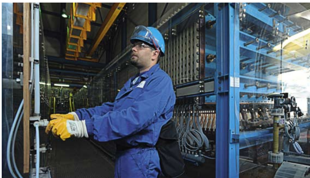
Umweltfreundliche Membranelektrolyse-Anlage der PCC Rokita SA in Brzeg Dolny
