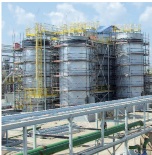
Bau der Ventilatoren-Kühltürme (links) und der Halb- und Fertigprodukt-lagertanks (rechts) der neuen Ethoxylierungsanlage in Plock, die Ende Oktober 2010 in Betrieb genommen wird.
