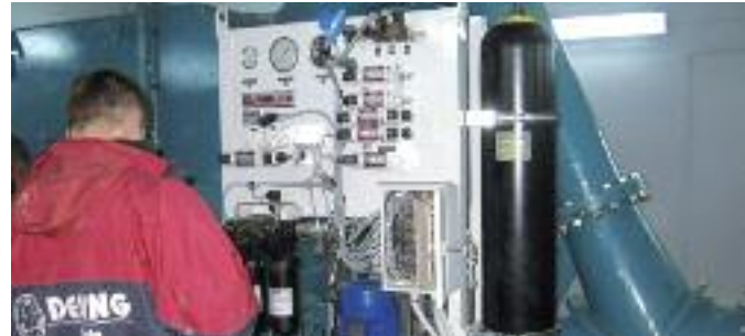
Technische Inbetriebnahme der Turbine
