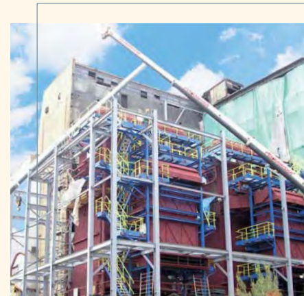
Das neue Heizkraftwerk der PCC Rokita wird u. a. die Fernwärmeversorgung für ca. 14.000 Einwohner in Brzeg Dolny sichern.
