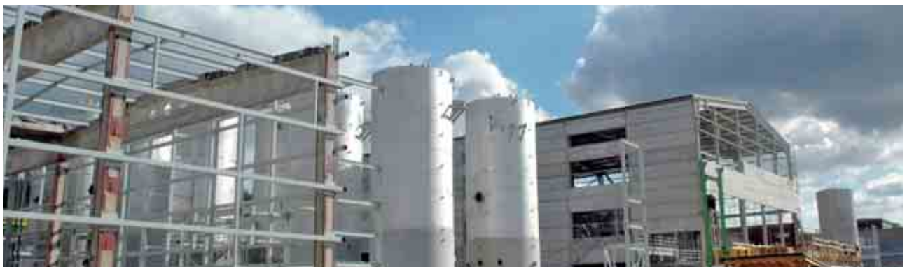
Rohbau der neuen Sulfonierungsanlage der PCC Rokita, die bereits Ende 2007 fertiggestellt werden soll
