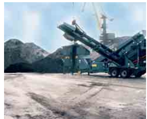
Absiebanlage der PCC in Kaliningrad
