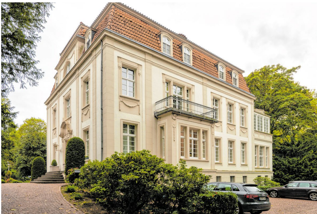
Denkmalgeschützt ist die PCC-Zentrale in Homberg innen wie außen. Es handelt sich um ein früheres Wohnhaus eines Zechendirektors, das PCC von Haniel erworben hat.
