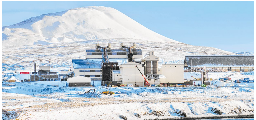
Im Schnee kaum auszumachen: die neue Siliziummetall-Anlage der Homberger PCC SE auf Isand.
