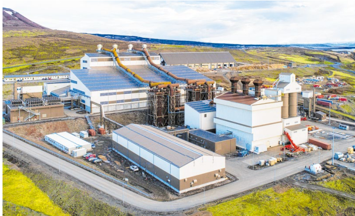
Im April und im August sind die beiden Öfen des PCC-Siliziummetallwerk in Betrieb gegangen. 265 Millionen Euro investierte das Unternehmen.
